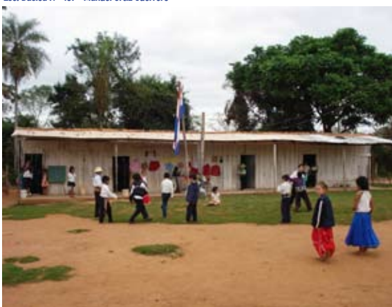
Esc. Básica Nº 7481 "Favio Ramón Morales", estructura de madera y techo de zinc. Muy precario estado.
