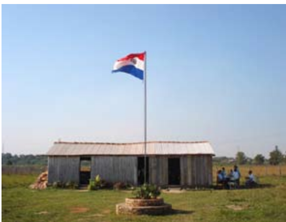
Esc. Básica Nº 7300 "Nuevo Horizonte", situación de precariedad extrema.
